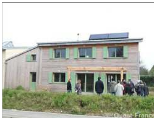
Des panneaux solaires pour la production d'eau chaude, une isolation performante, une étanchéité à l'air rigoureuse et un chauffage par poêle à bois, résumant les clefs d'accès au label BBC.
